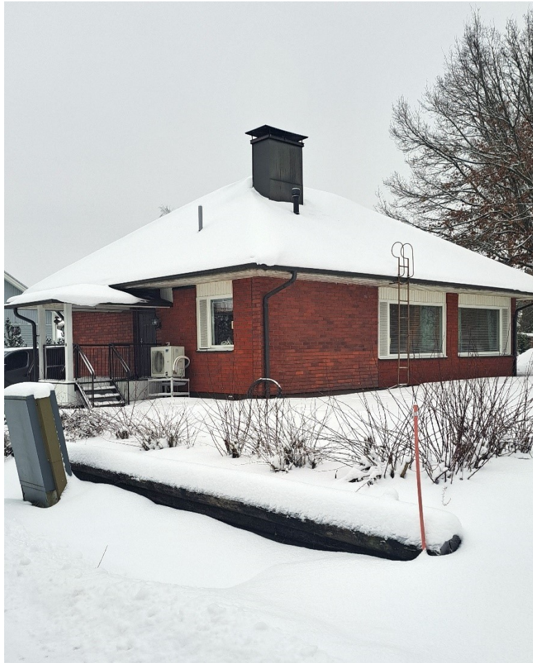
Kuva 2. Tontilla sijaitseva asuinrakennus Viholankadulta kuvattuna. © Tampereen kaupunki 2026.
